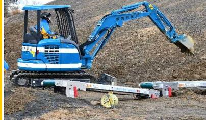
埋没した家屋周辺の土砂を重機によって排除
